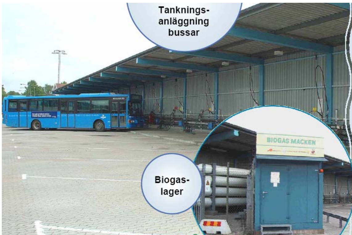
Kuva 4. Trollhättanin bussivarikon biokaasutankkauskalustoa (Svensson 2006).
