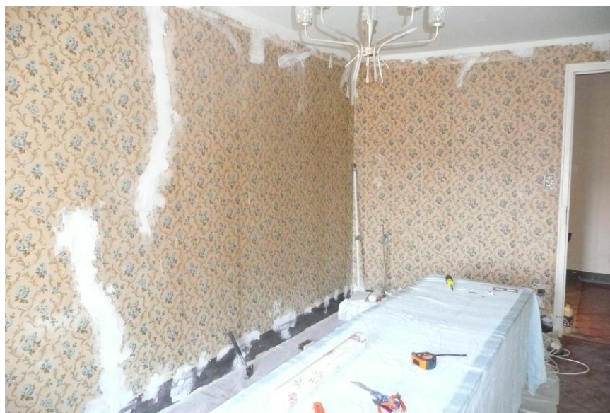
Makuuhuone hionnan ja katon maalaamisen jälkeen
