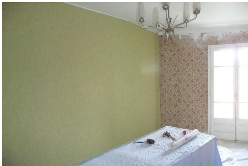
Ensimmäinen seinä tapetoitu
